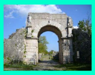
accedeva da una scala laterale. All'interno vi è un cortile di sicurezza chiuso verso la città da un portone ligneo. Le altre porte riproponevano la medesima struttura: un unico fornice (apertura), le due torri laterali, la corte di sicurezza interna e la controporta a doppio battente.
